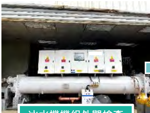
冰水機機組外觀檢查
