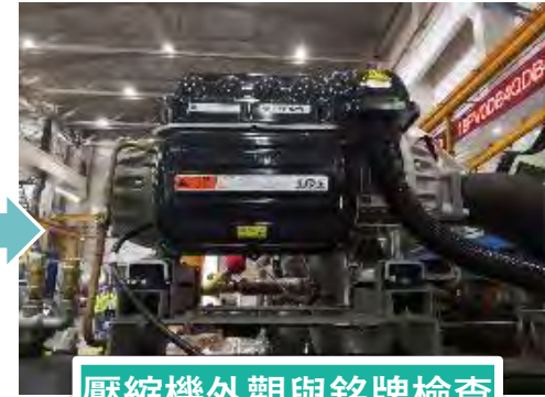
壓縮機外觀與銘牌檢查
